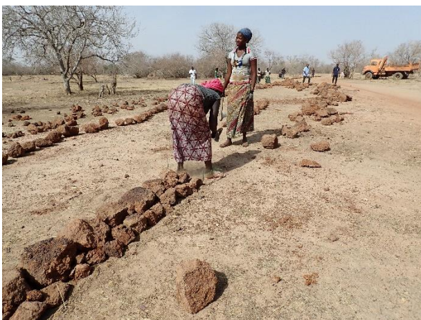
Pose de cordons pierreux
