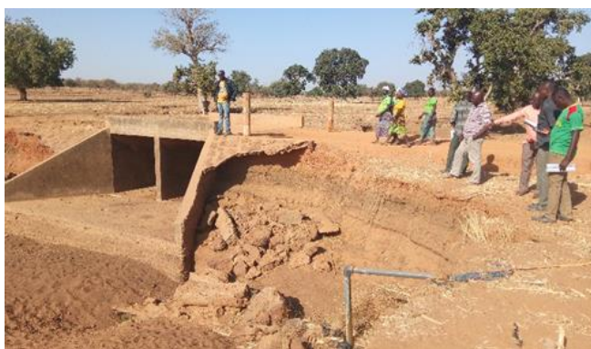
Mission d'observation du bureau d'étude de l'état des lieux de la piste Gayeri -Soualimou : aval d'un dalot 2x2x2 au Pk 0+215
