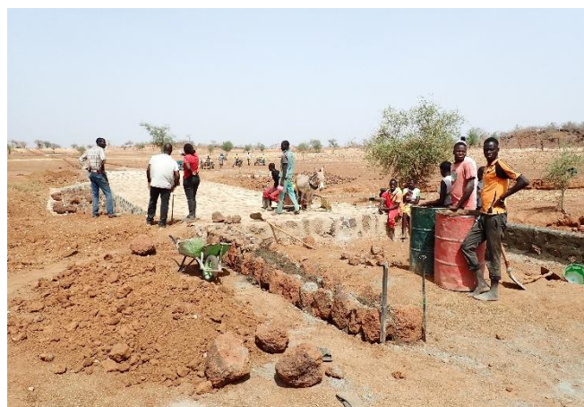
Mission de supervision des travaux (Piste Bassiéri-Boungou-Dipienga)
